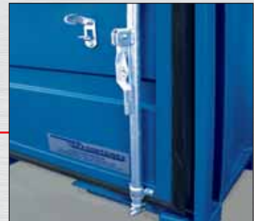
дверь с резиновой прокладкой и запирающим механизмом
